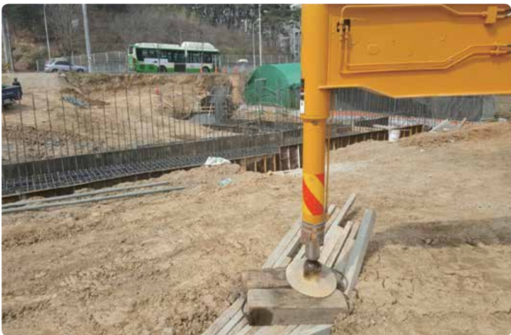
[사진 2] 좌측 아웃트리거 설치 지반 침하상태
