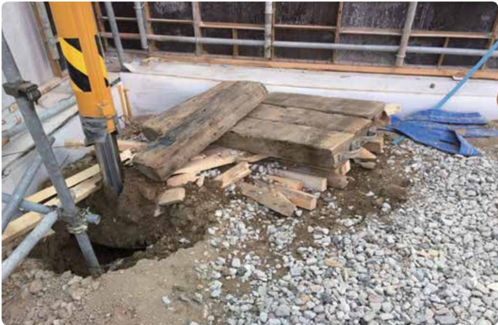
[사진 1] 재해 직후 아우트리거 상태
