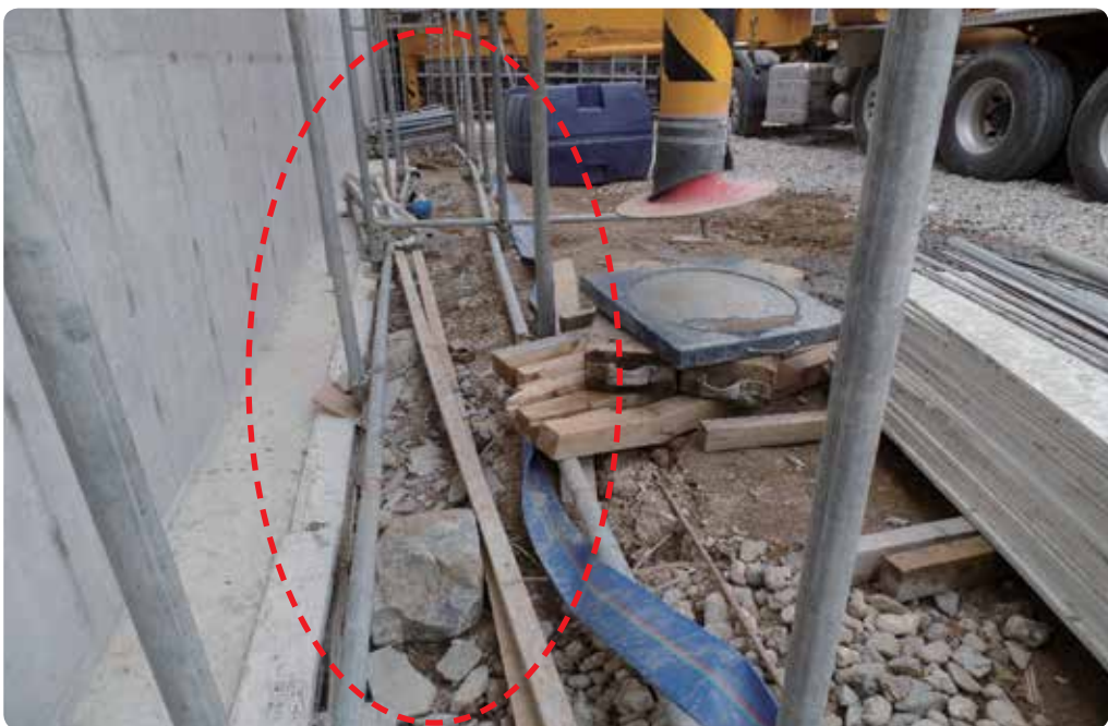
[사진 2] 펌프카 아우트리거가 설치된 되메움 지반
