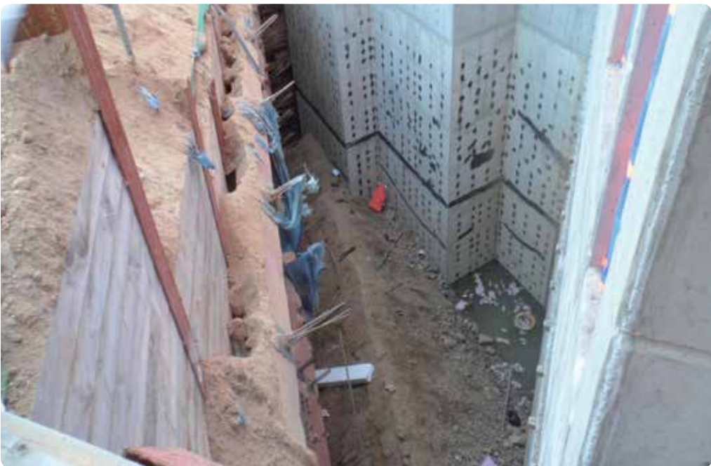
[사진 2] 재해발생 지점인 흙막이가시설 해체구간 모습
